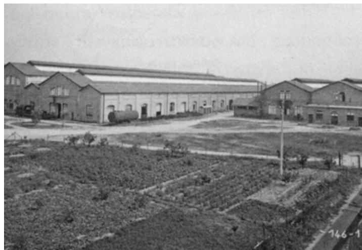
La Nuova Officina con i capannoni destinati ai vari reparti
