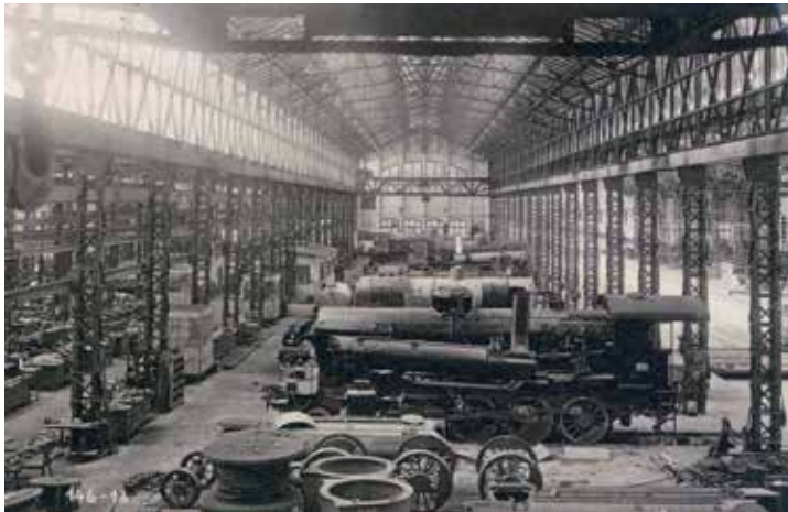
Reparto montaggio locomotive a vapore primi decenni del secolo
