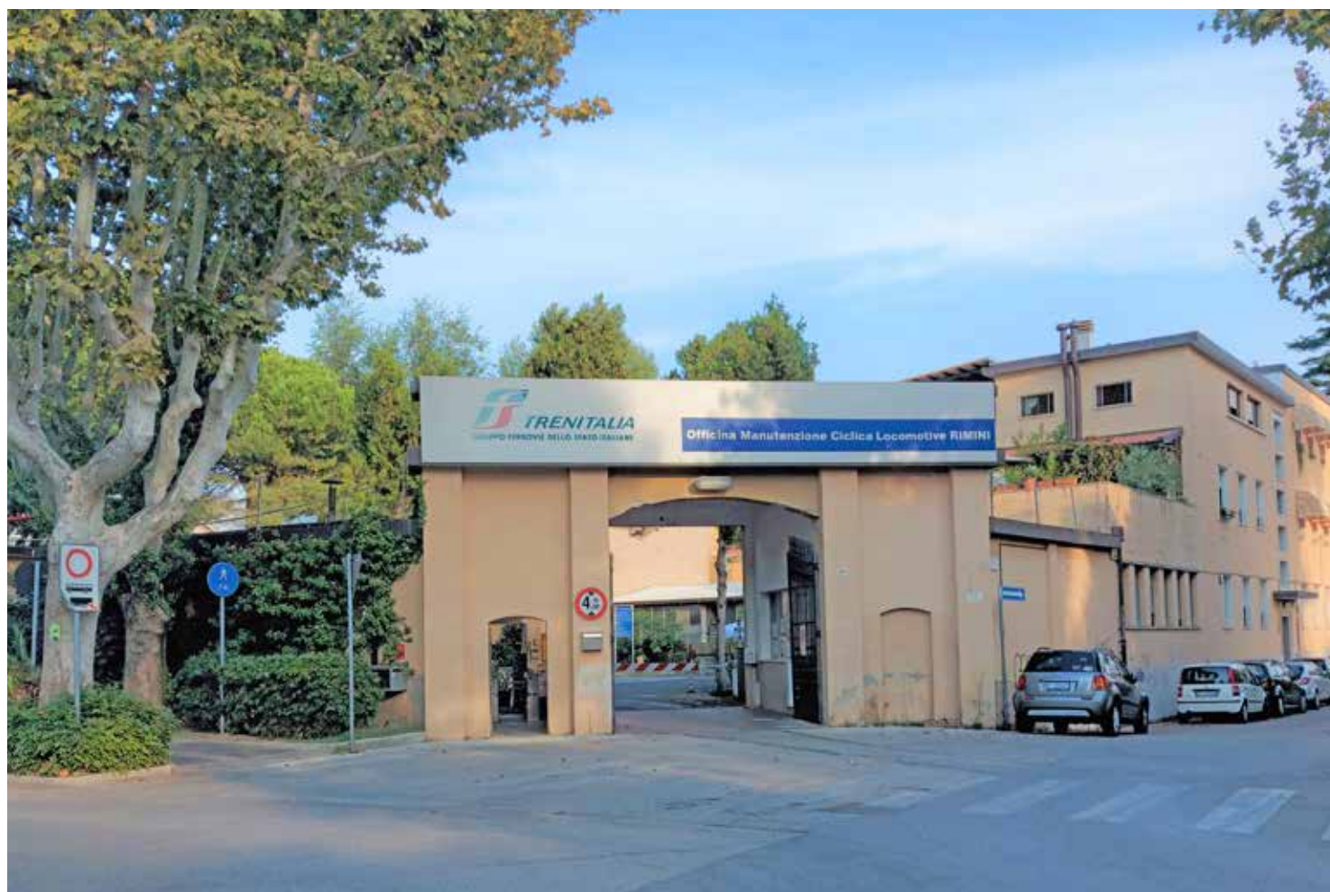
L'ingresso attuale dell'Officina Manutenzione Ciclica Locomotive Rimini
