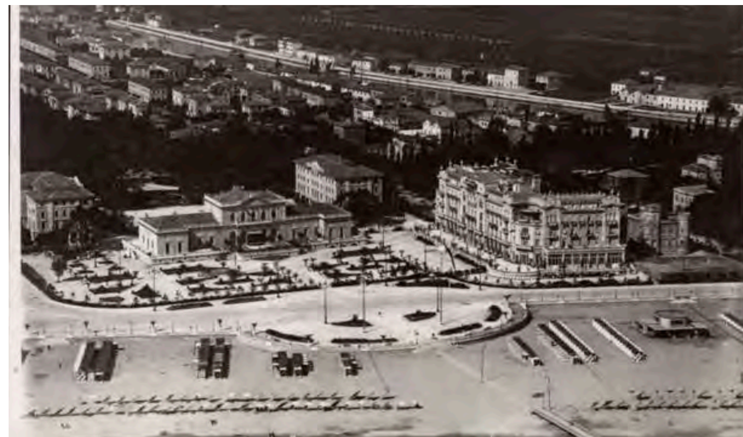
Il Kursaal , le palazzine Roma e Milano e il Grand Hotel negli anni trenta del secolo scorso.
